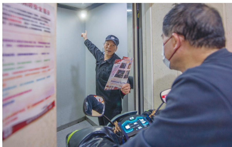
鼓楼街天霖园居民楼内安装梯控系统,电动自行车进入电梯时,监控摄像头会自动识别并闪灯报警,同时“拒载”。
