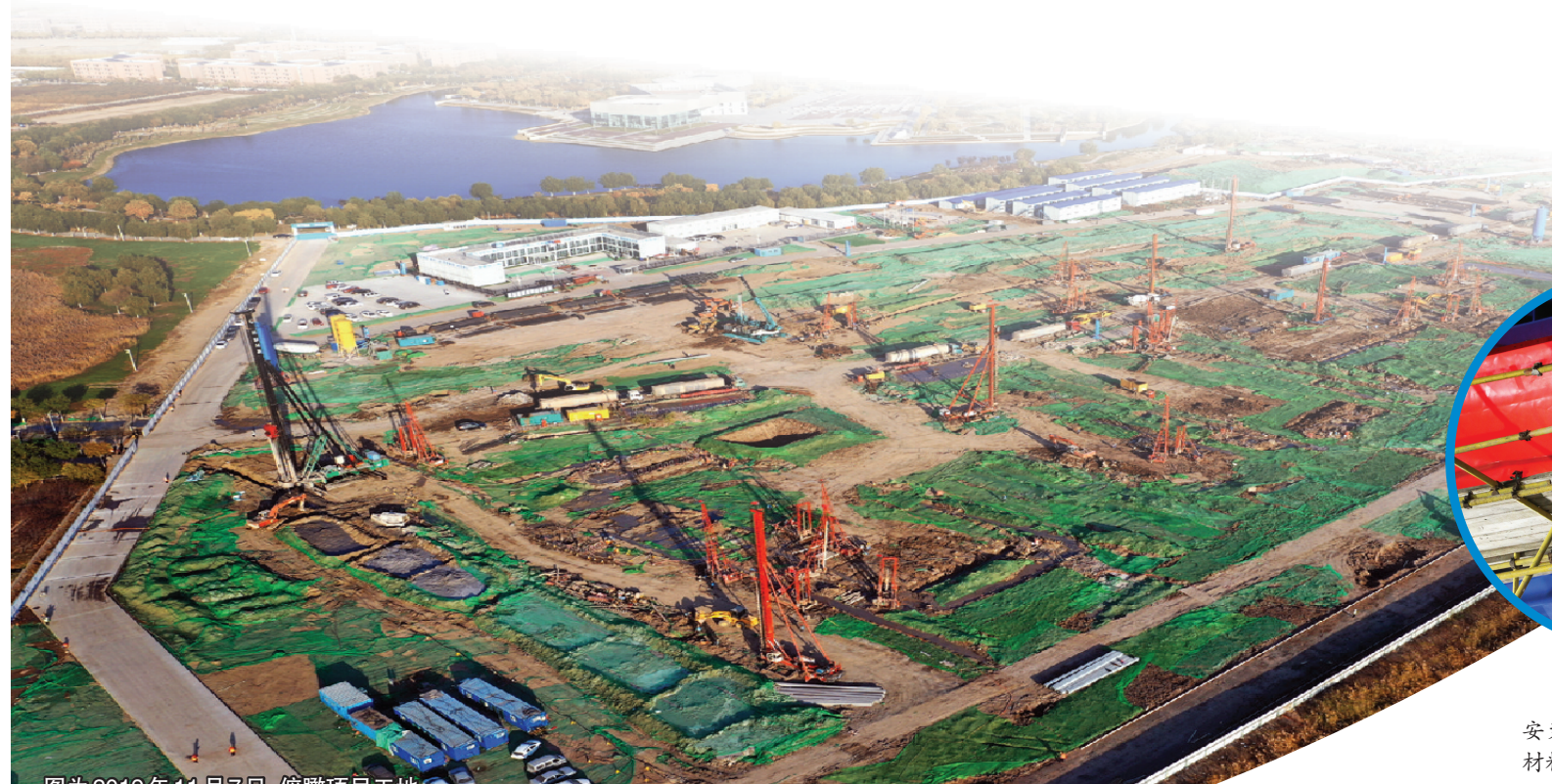
图为2019年11月7日,俯瞰项目工地。
