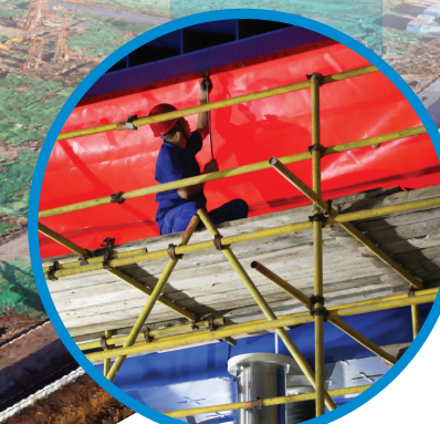
图为2023年9月29日,安装水下振动台底部防水材料。
