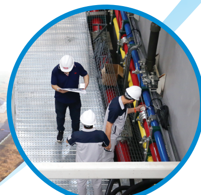
图为2023年9月18日,大型振动台安装过程检查。
