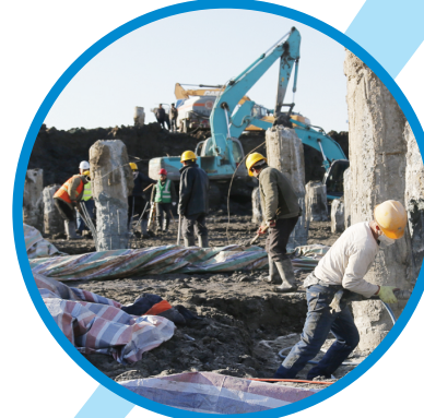
图为2019年12月19日,地基施工中。
