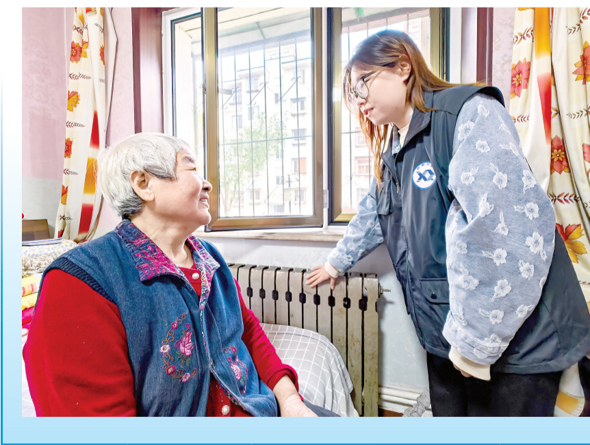
连日来,西青区张家窝镇杰盛里社区入户检修排查暖气管道,网格员走进辖区内独居、空巢老人家中,排查暖气管道漏水、堵塞等问题,做足准备让老人安全过冬。 本报记者 潘立峰 通讯员 刘臣 摄
