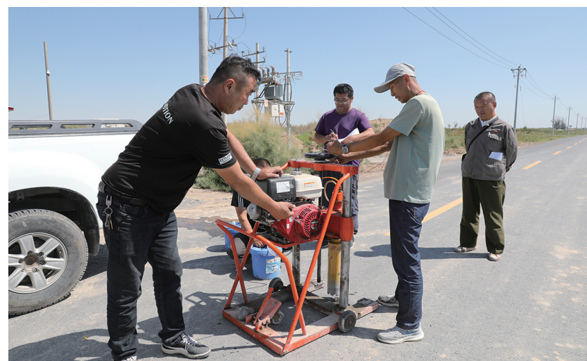
2023年8月17日,十一师龙河农场农村公路项目顺利通过竣工验收。该项目是十一师“十大民生工程”之一。图为检测组进行钻芯取样。 潘彩兰 摄
