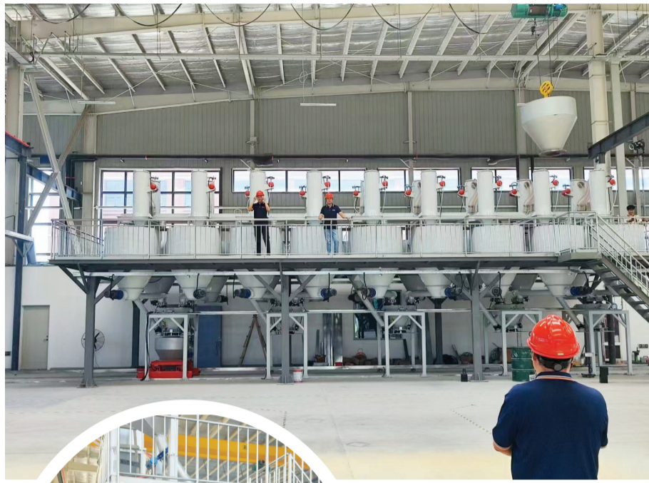
天润瀚阳生产线安装调试现场。
