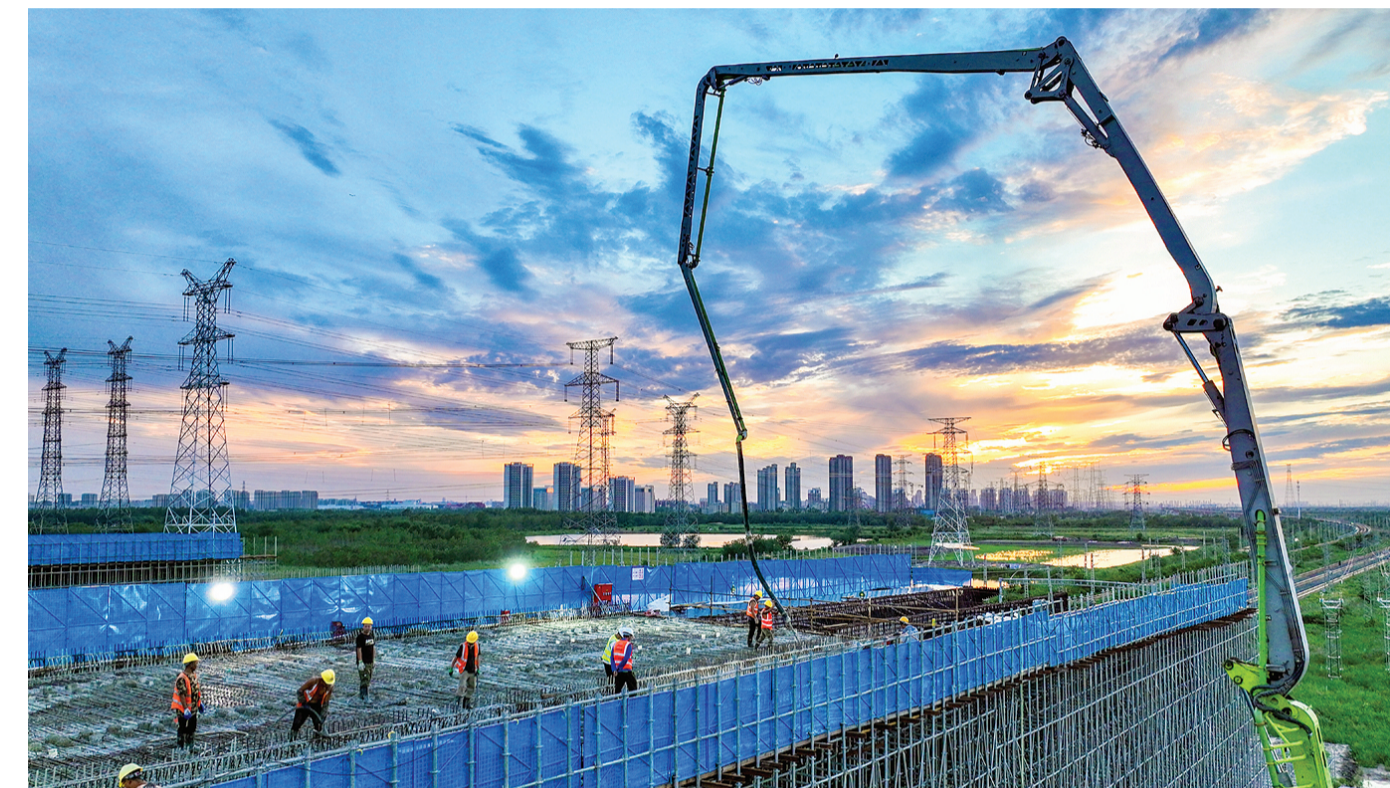
日前,由中铁十六局承建的东屯北路上跨北环铁路立交桥梁体部分正式展开施工,这是东屯北路工程关键性节点。东屯北路南起津汉公路,与丽湖环路连接,建成后可有效缓解东丽湖通往津汉公路、空港等方向的交通压力。 本报记者 张磊 通讯员 马鲁萍 摄
