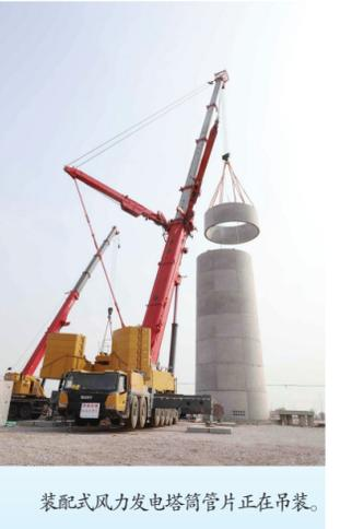
装配式风力发电塔筒管片正在吊装。
