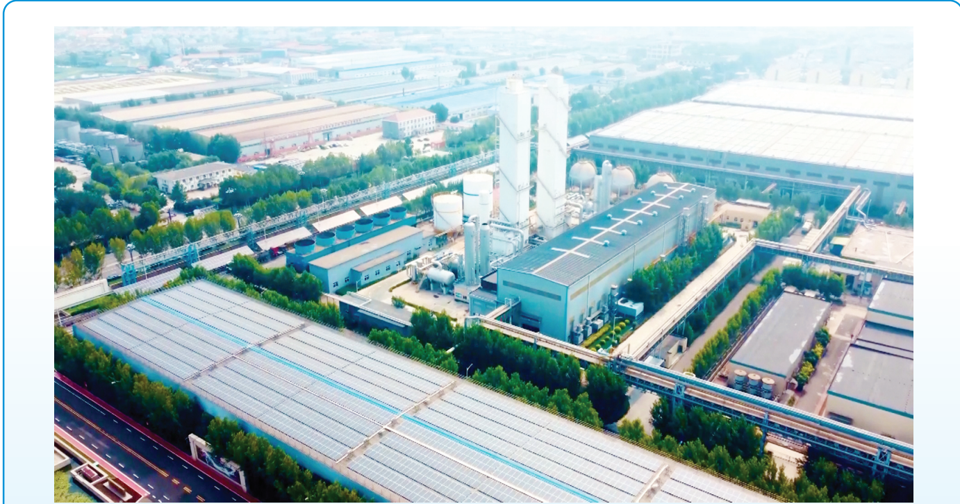
新天钢42兆瓦屋顶光伏项目 年减少二氧化碳排放量4.1万吨
