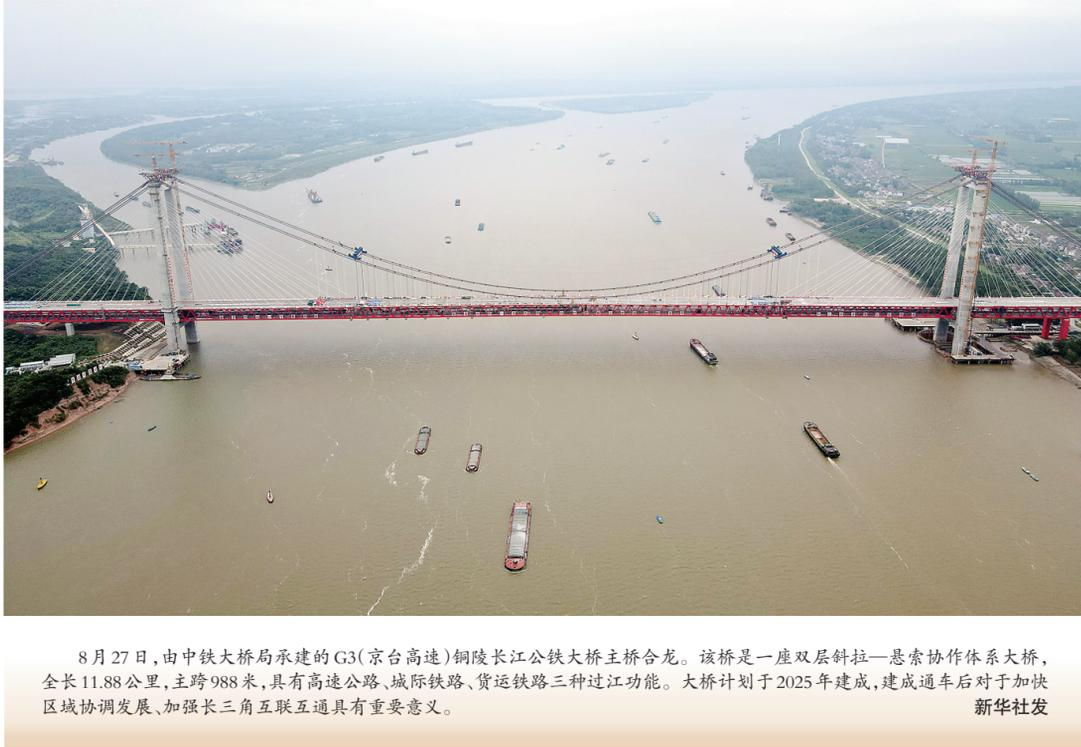
8月27日,由中铁大桥局承建的G3(京台高速)铜陵长江公铁大桥主桥合龙。该桥是一座双层斜拉—悬索协作体系大桥,全长11.88公里,主跨988米,具有高速公路、城际铁路、货运铁路三种过江功能。大桥计划于2025年建成,建成通车后对于加快区域协调发展、加强长三角互联互通具有重要意义。
