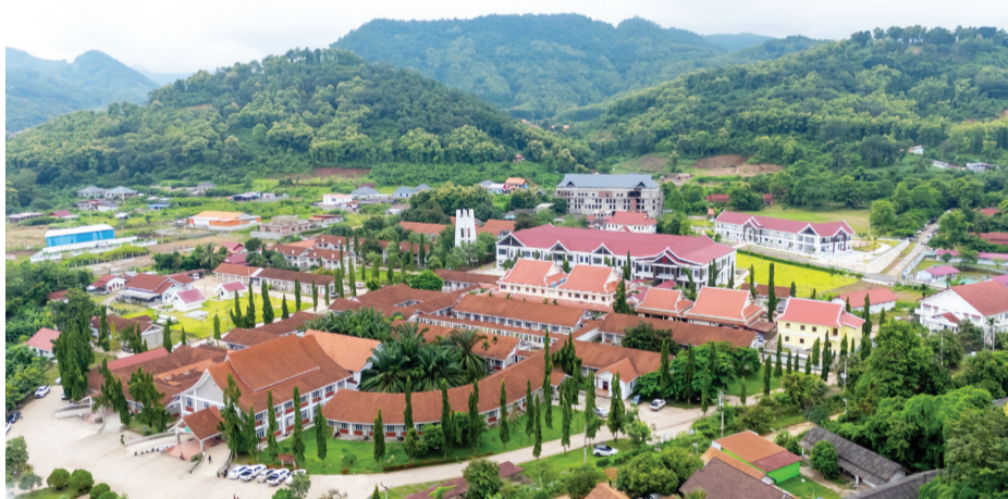
中国援老挝琅勃拉邦医院升级改造项目16日正式启用并移交老方。老挝卫生部、老中合作委员会以及中国驻老挝大使馆和项目建设单位等相关人员出席移交仪式。老挝琅勃拉邦医院由中国援建,本次升级改造项目包括新建外科和心血管科楼、中国专家公寓、污水处理站、消防水池和水泵房,维修改善此前援建建筑并提供相关设备。
