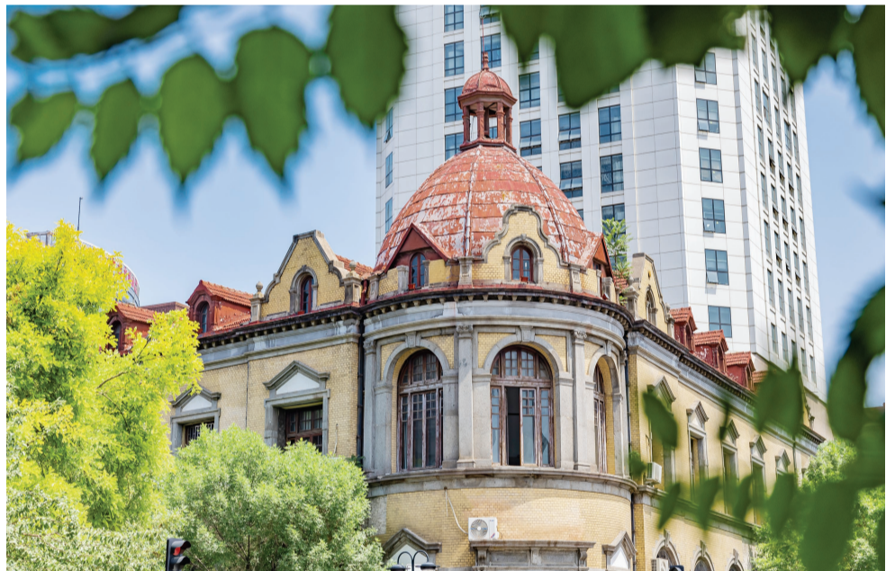
解放北路123号原华俄道胜银行,于1900年兴建。此楼为天津唯一使用穹顶、采光亭的银行建筑,极具特色。
