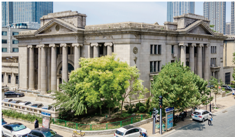
解放北路86号,原汇丰银行大楼,1925年竣工,建筑整体并无过多修饰,外观浑然一体,汇丰银行天津分行也是天津第一家外资银行。
