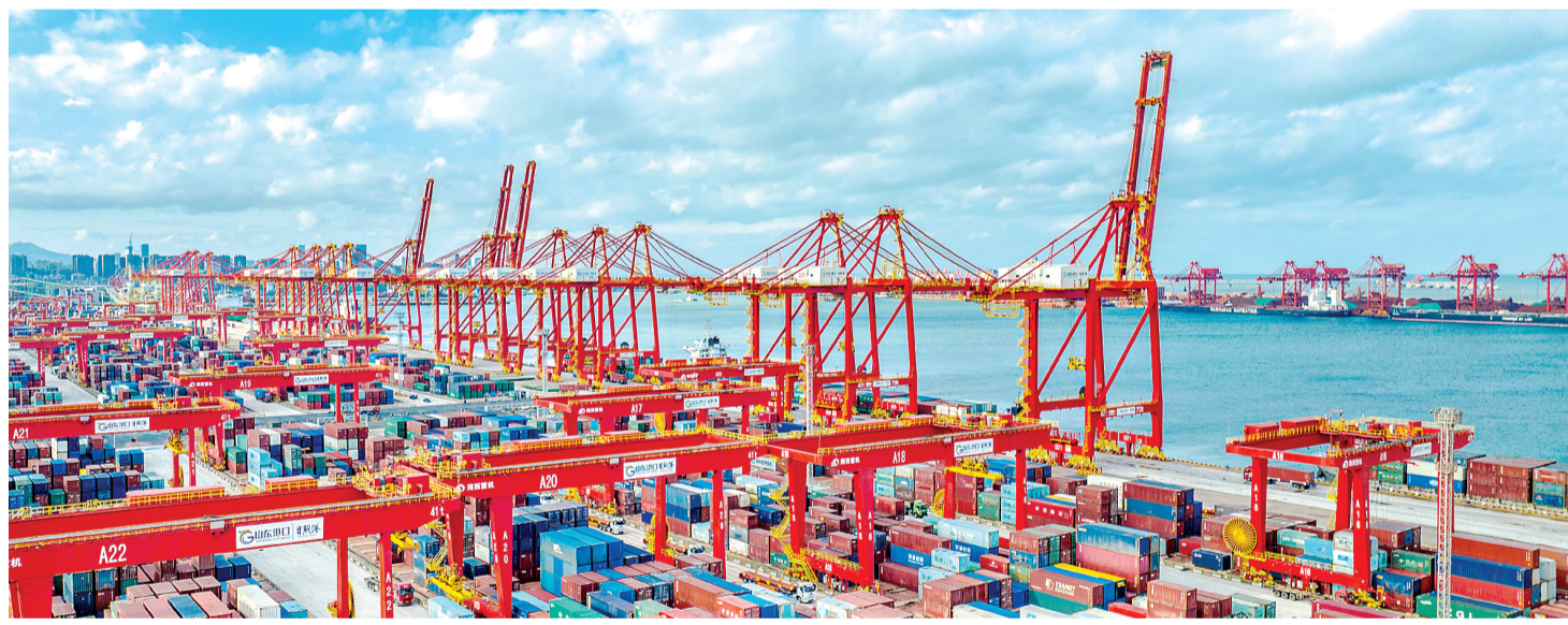
2024年7月2日拍摄的山东港口日照港集装箱码头(无人机照片)。新华社发
