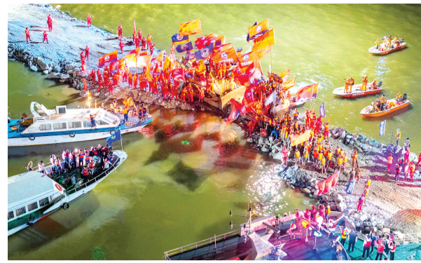
7月8日晚拍摄的团洲垸洞庭湖大堤决口封堵现场(无人机照片)。
