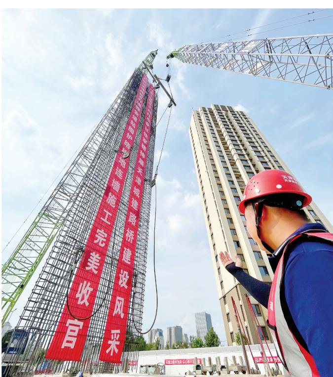
昨天,天津城建集团路桥建设公司承建的天津地铁8号线延伸线雅安道站连续墙钢筋顺利入槽,标志着地铁8号线延伸线全线车站主体结构全部完成,进入主体施工阶段。
