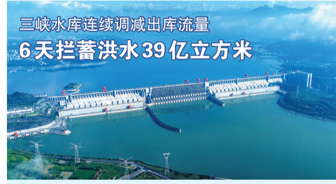
7月3日,据三峡集团消息,为缓解长江中下游防洪压力,三峡集团执行水利部长江水利委员会调度指令,将三峡水库出库流量逐步调减至14000立方米每秒,6月26日至7月1日,三峡水库累计拦蓄洪水39亿立方米。图为三峡枢纽工程。 新华社发
