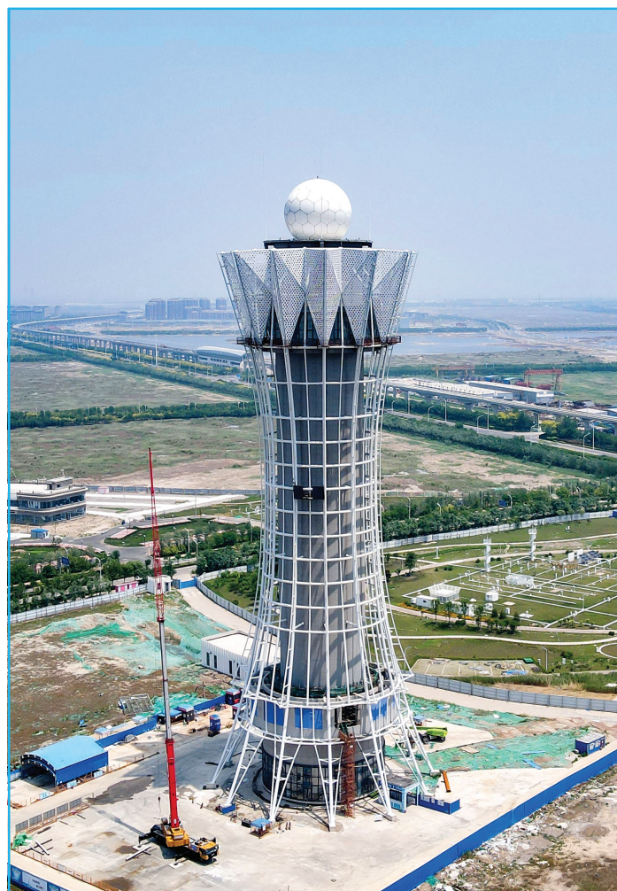
目前,滨海新区气象局新一代天气雷达塔工程施工接近尾声,即将投入运行。天气雷达塔工程位于中新天津生态城,形似“话筒”,高56米,建成后将为渤海、黄海海域和华北地区提供气象探测预报,在防灾减灾方面发挥效用。 本报记者 吴迪 摄
