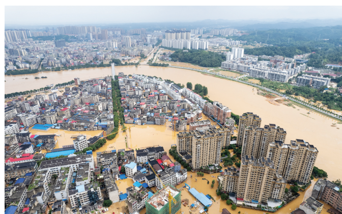
这是7月2日在湖南省岳阳市平江县县城拍摄的内涝现场(无人机照片)。
