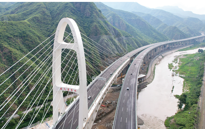
7月1日,京蔚高速北京段(西六环—灵山互通立交)正式通车。从北京西六环军庄立交驾车至灵山,由2小时缩短至45分钟。京蔚高速北京段建设期间名为国道109新线高速,开通运营后,将缓解北京西北、西南通道交通压力,助力京津冀协同发展。 新华社发
