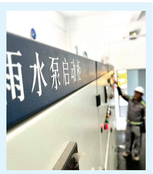
作为2024年民心工程之一的津滨雨污水合建泵站改建工程全部完工,开始试运行。此次工程更新了水泵、格栅除污机、高低压配电柜等,在今夏汛期对部分地区排水功能起到积极作用。
