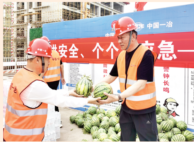
近日,我市连续高温天气,中国一冶为北京协和医学院天津医院生活附属区一线作业人员送去西瓜、矿泉水、藿香正气水等防暑物资,保障安全生产。 本报记者 张磊 摄
