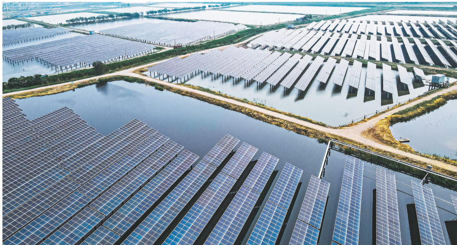
西青区大寺镇120兆瓦渔光互补光伏发电项目并网运行2个多月以来，已高效输出绿色电能超5亿千瓦时，相当于减少二氧化碳排放约4.78万吨。本报记者 潘立峰 通讯员 王洪月 摄
