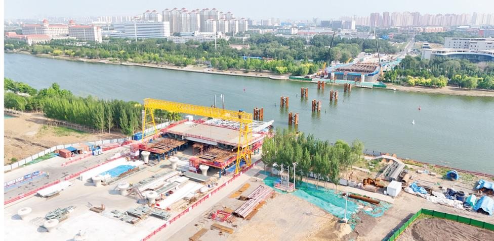
柳悦桥项目钢箱梁开始顶推施工。
