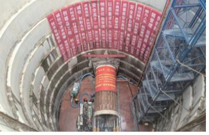
5月18日,随着1号竖井顶管机徐徐转动,由中铁十八局参建的环北部湾广西资源配置工程北海供水片区先行开工建设工程——龙港新区应急供水工程全线第二台硬岩顶管机顺利始发,标志着该工程建设进入新阶段。 陈凡
