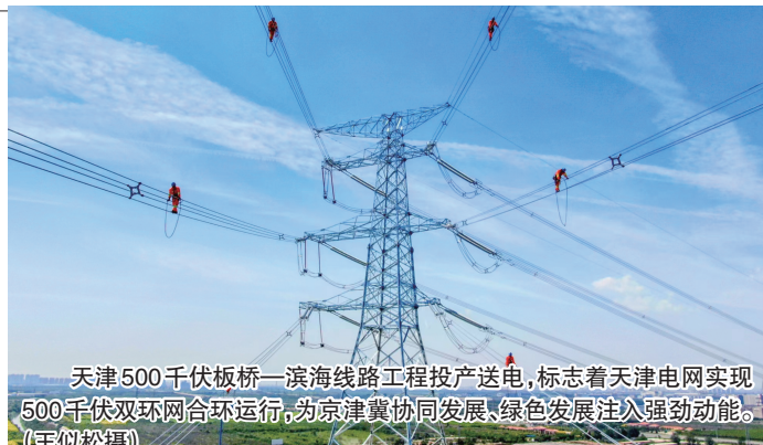
天津500千伏板桥—滨海线路工程投产送电,标志着天津电网实现500千伏双环网合环运行,为京津冀协同发展、绿色发展注入强劲动能。(任松摄)
