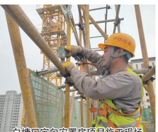
白塘口定向安置房项目施工现场
