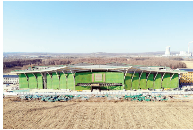
随着天气渐暖,我国在建最长高铁站——伊春西站达到复工条件,近日全面复工建设。图为伊春西站施工现场。
