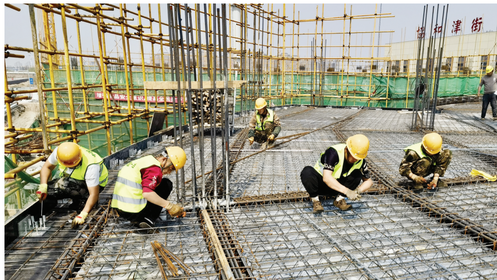
清明假期，中国一冶近400名建设者坚守在京津冀重点项目北京协和医学院天津医院建设工地，力争6月底实现生活附属区一期主体结构封顶。
