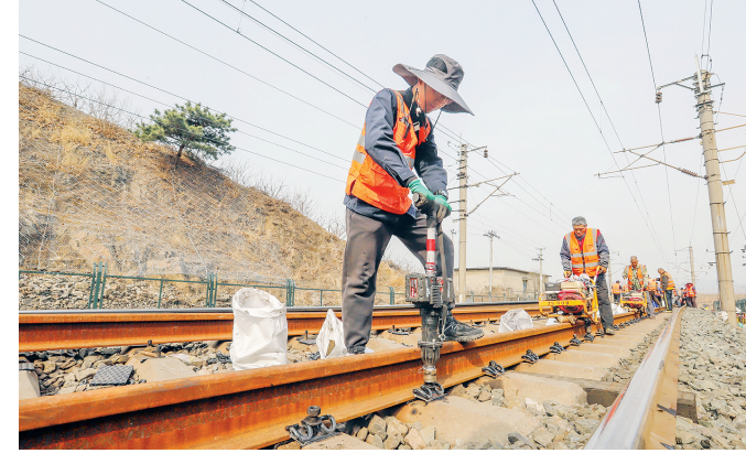
图为工人在河北省遵化市境内的大秦铁路进行维修施工。
