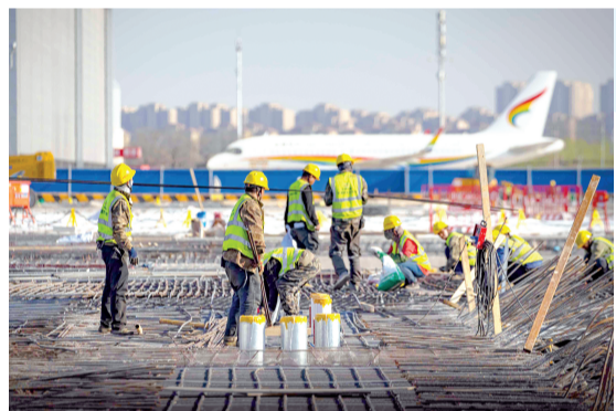
空客天津第二条总装线总装厂房施工现场。照片由中国铁建大桥局提供
