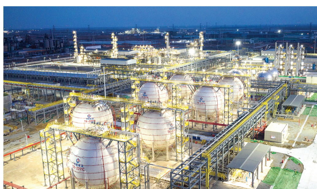
3月18日,渤海油田最大天然气处理厂——位于山东的滨州天然气处理厂正式向环渤海地区供气,我国北方海上油气资源外输和保供能力取得新突破。图为滨州天然气处理厂一角(无人机照片)。
