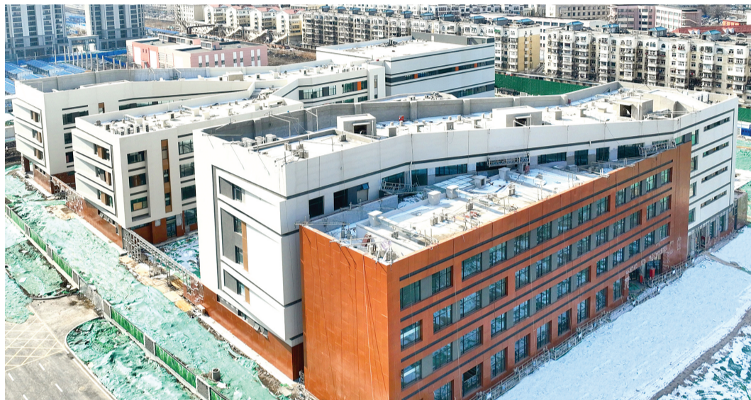
由中建六局承建的华东师范大学滨海附属学校项目已全面复工复产,今年9月将投入使用。 本报记者 张磊 通讯员 苏婷 摄
