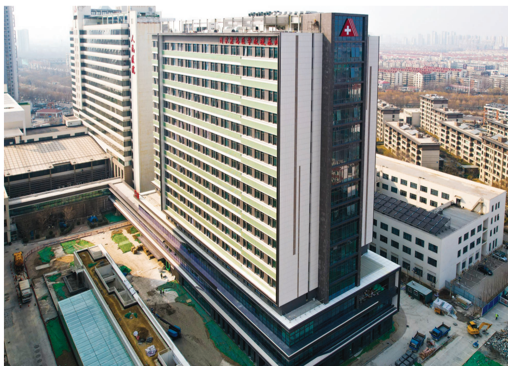
由中建三局承建的天津市人民医院扩建三期工程(住院楼)已进入最后收尾阶段,预计3月底竣工,投用后将为市民提供更为完善的医疗服务。
