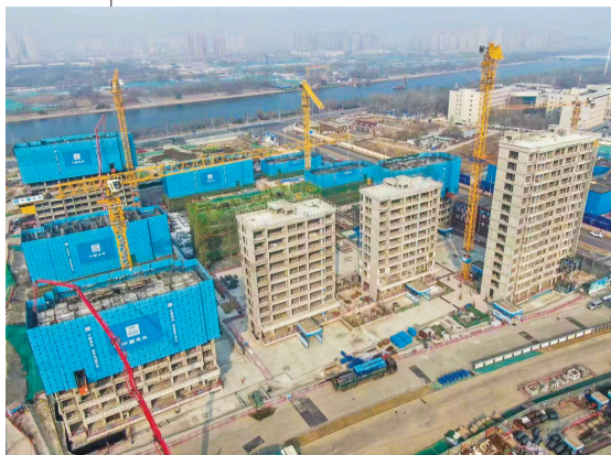
俯瞰柳林城市更新一期项目。
