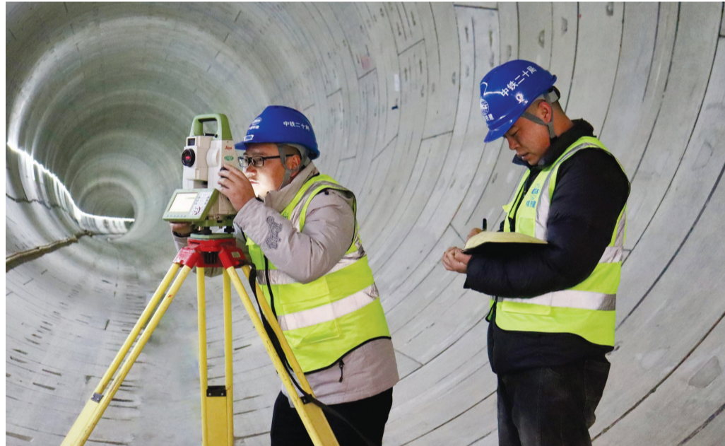
中铁二十局施工人员在地铁8号线一期长泰河东站展开大干90天劳动竞赛活动。天津地铁8号线一期投用后将是我市首条全自动运行线路。
