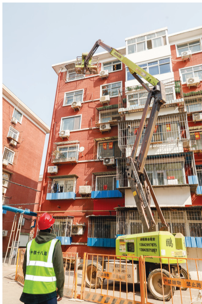
中铁十八局工作人员在滨海新区福星里小区进行提升改造施工。2024—2025年度滨海新区远年住房和老旧小区改造工程已全面开工,此次提升改造涵盖107个老旧小区,1559栋楼房,到今年底将提升6万余户居民居住环境。
