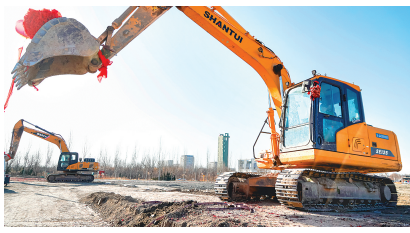
东鹏饮料天津生产基地开工现场。本报记者 潘立峰 通讯员 陈奕如 摄
