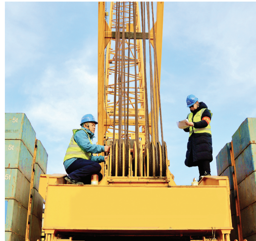
春节过后,中铁十八局施工人员投入到滨海新区西中环快速路跨海河桥工程项目的紧张施工之中,全力以赴冲刺新春“开门红”。 本报记者 张磊 通讯员 周美玲 摄
