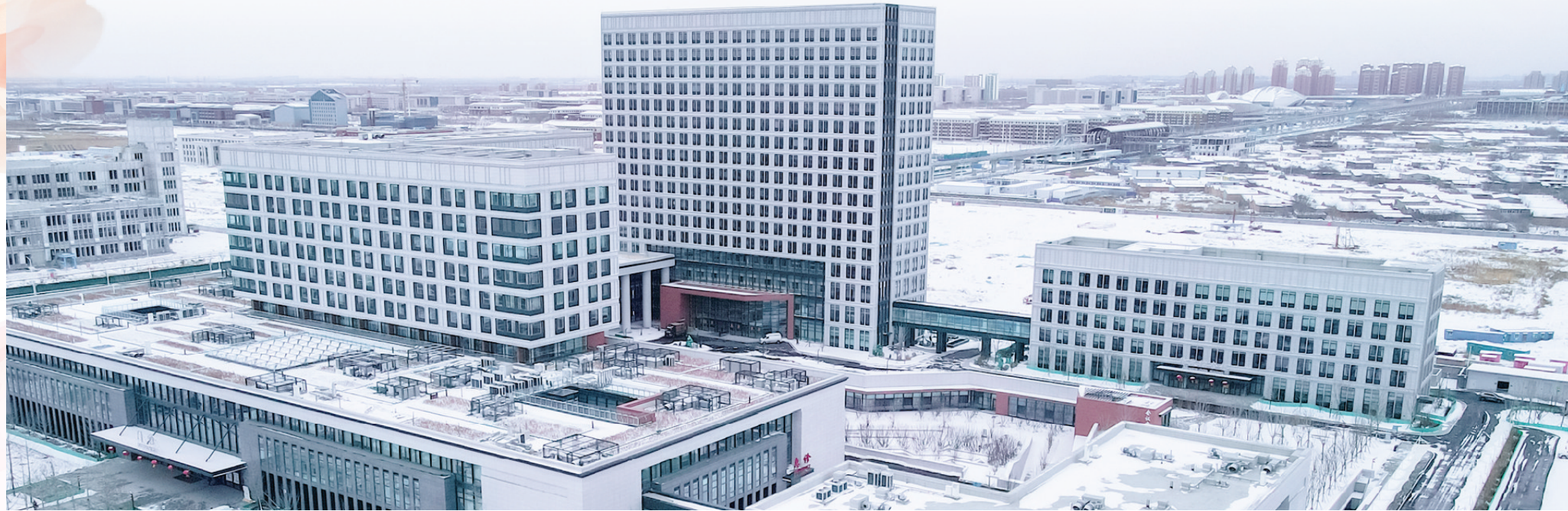
北京协和医学院天津医院(一期)项目交付并投入运营,缓解北京就医压力。
