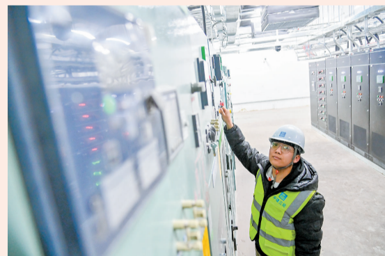
春节假期，中建三局的机电工长李于怡在位于武清区的中国联通京津冀数字科技产业园新建项目进行设备调试。 本报记者 张磊 摄
