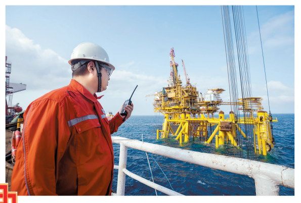
图为刘斌在“深海一号”二期工程安装现场指挥施工作业。 照片由海油工程提供
