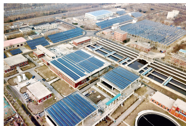
近日,北仓污水处理厂分布式光伏发电项目实现全容量并网发电。该项目装机容量4.1兆瓦,年发电量420万度,预计每年可减少二氧化碳3697吨。 本报记者 胡朝伟 张磊 摄影报道
