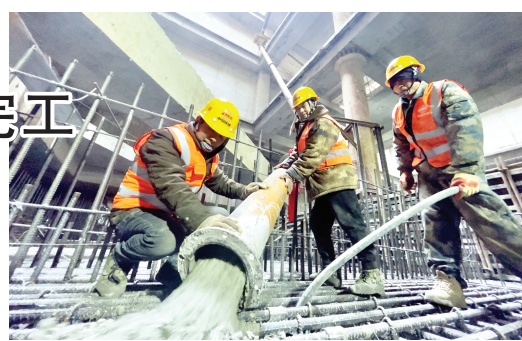
土浇筑。施工人员在地下进行混凝土浇筑。本报记者 张磊 摄
