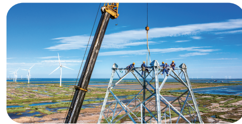
▲国网天津电力员工在大港500千伏线路工程现场组立铁塔。
