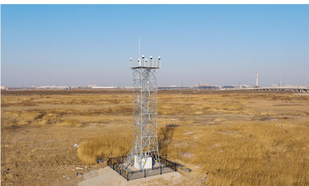
近日,天津经开区西区双城绿廊瞭望塔顺利建成。双城绿廊瞭望塔集火情瞭望及防火监控等功能于一体,将成为天津经开区西区防火新“神器”,守护万亩双城绿廊。据了解,瞭望塔塔高18米、塔宽4米,塔顶安装了800万像素40倍变焦激光云台摄像机6台,其中4台远景、2台近景实现了无死角监控。本报记者 赵建伟 摄
