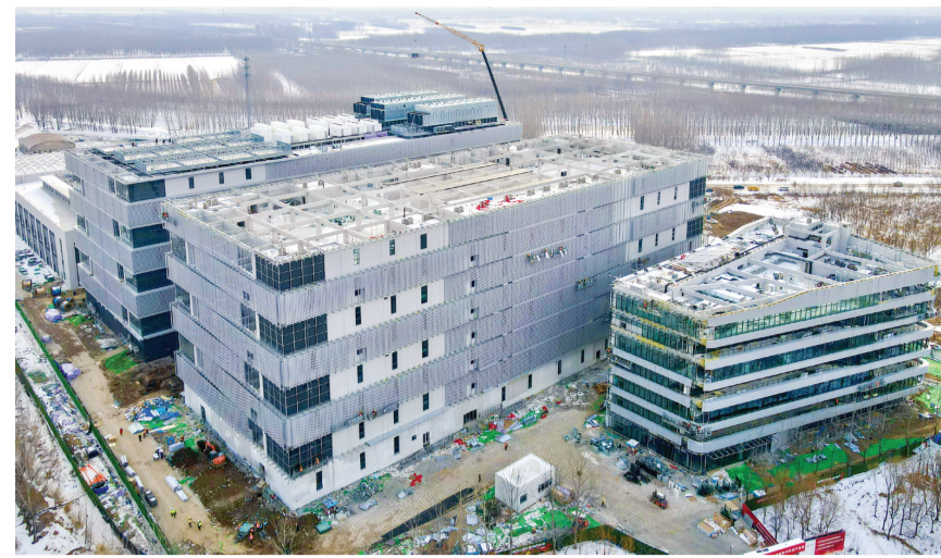
目前,中国联通京津冀数字科技产业园项目已具规模,将于今年3月整体竣工交付。项目位于武清区高材科技创新园,建成后将成为国家级枢纽数据中心,服务京津冀大数据综合试验区。 本报记者 张磊 摄
