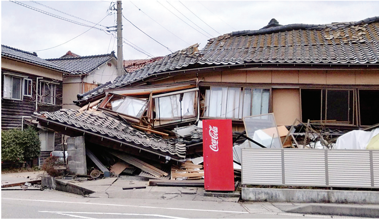
图为1月1日在日本石川县轮岛市河井町拍摄的受损房屋。
