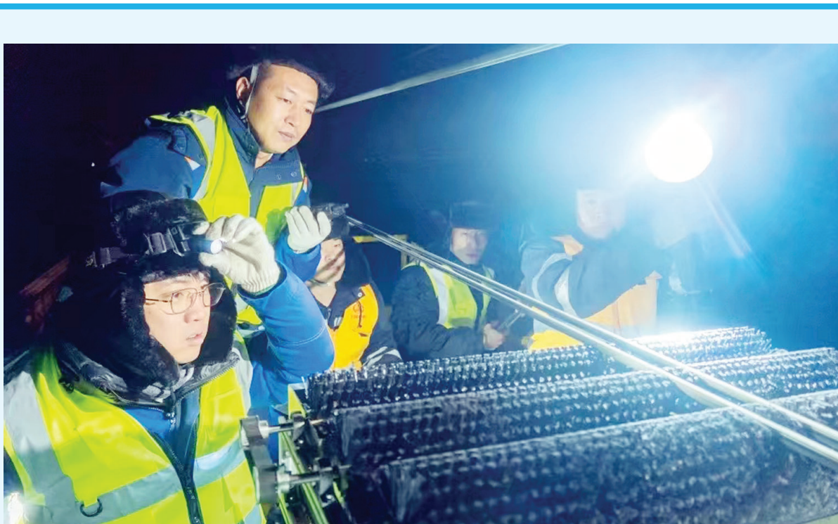
地铁工作人员利用自主研发的自动喷涂装置,对9号线露天道岔喷涂防冻液。 通讯员 苏晨 本报记者 张磊 摄
