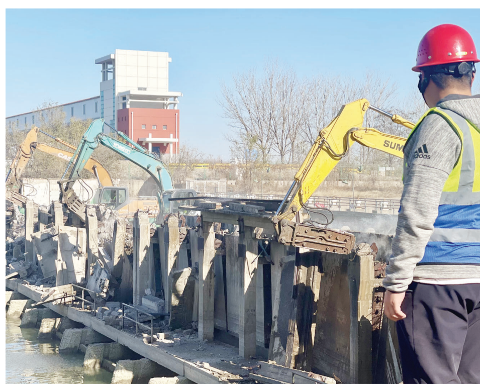
独流减河低水闸位原址拆除扩建工程正式启动,项目位于静海区独流镇十一堡,计划2024年11月完工,工程建成后,可提高大清河系防洪保障能力。
