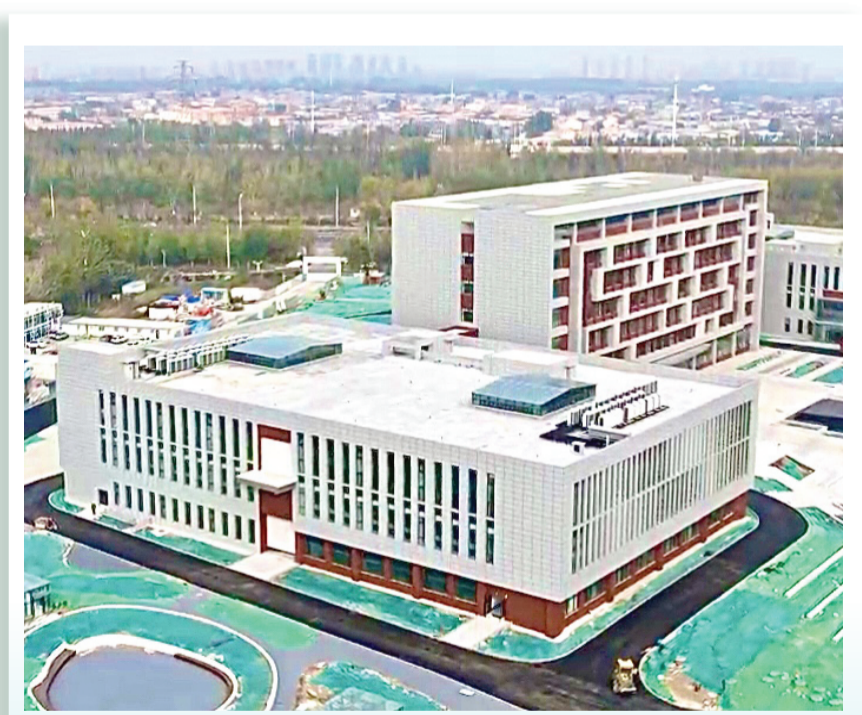
近日,天津职业大学智能制造产教融合实训中心项目已全部完工。该项目位于北辰区,投用后将提升天津职业大学的社会服务能力。本报记者 张磊 摄
