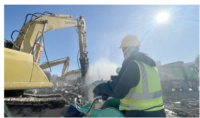
工人进场施工。 造11个老旧小区,涉及晨光楼、晨阳里、时尚花园三个社区。
