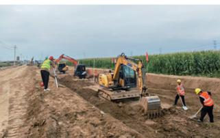
不负秋日好时光,施工大干一线忙。10月23日,中铁十七局承建的山西文水美丽乡村项目一次网主支线、支线全部完成,标志着从热源到换热站的线路已经联通。(文图/胡浩 王秀秀)
