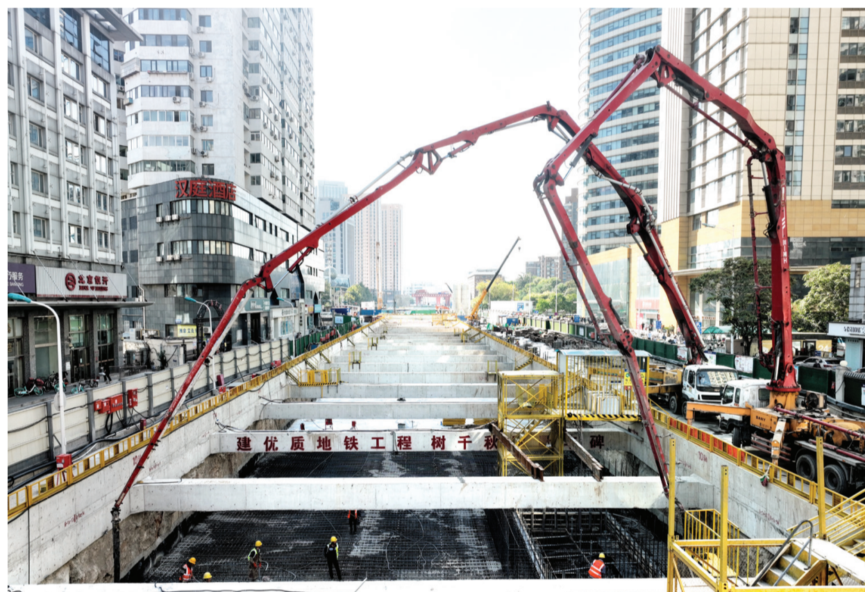
昨天,天津地铁8号线一期工程湘江道站主体结构顺利封顶。8号线一期工程是我市中心城区南部骨干轨道交通线路,途经南开、和平、河西三个行政区。
