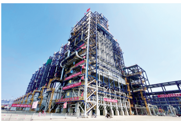
天津南港乙烯及下游高端新材料产业集群项目。
